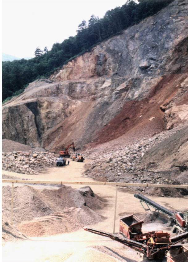
Slika 1.1 - Kamenolom tehničkog kamena - Vukov Dol, Geomid d.o.o.
